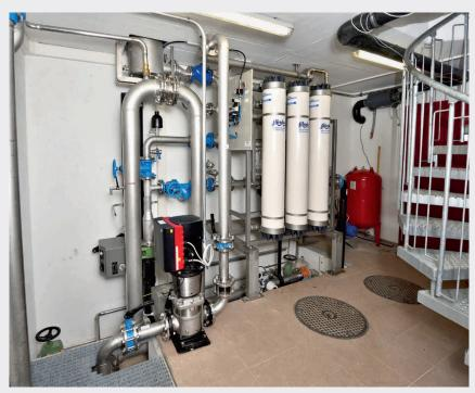
Fig. 10 Die Ultrafilteranlage FILADOS W.E.T. pur. Links vorne die Spülwasserpumpe, links neben den Membranen die Ventilinsel für die Verteilung der Steuerluft zu den pneumatischen Klappen und über dem Löschbogen die nach oben versetzte UV-Anlage.
