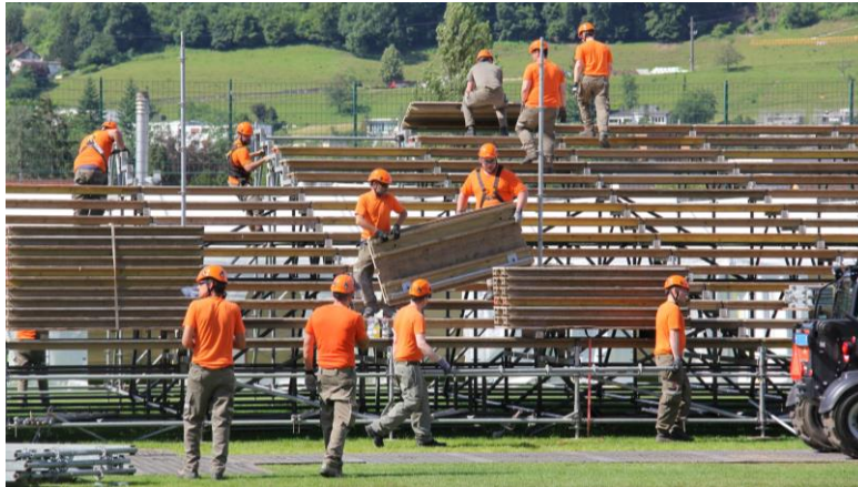
Aufbauarbeiten am Nordwestschweizerischen Schwingfest in Lausen.
