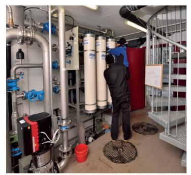
Ultrafilteranlage mit drei Membranmodulen
