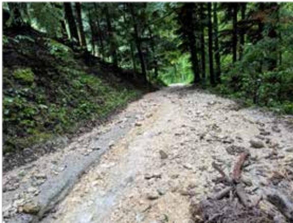
Freigespülte alte Reservoirleitung im Wäldeli
